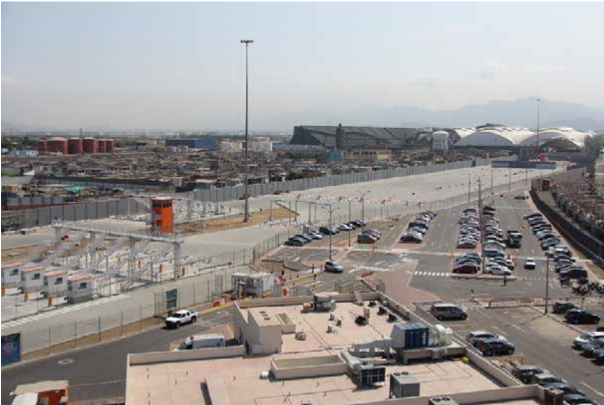
Figura 36 – Vista del antepuerto de APM Terminals Callao – Fuente: APM Terminals Callao
