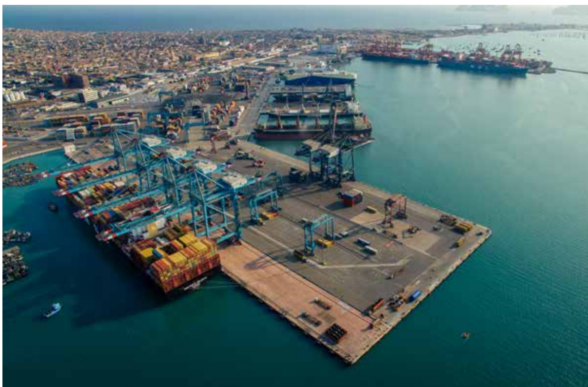
Figura 15 – Terminal Norte Multipropósito del TP del Callao – Fuente: APN
